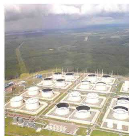
俄罗斯鞑靼石油公司石油化工项目 地坪 水池 混凝土浇筑量：50000m 3 使用材料：PNC803、PNC401、PNC101
